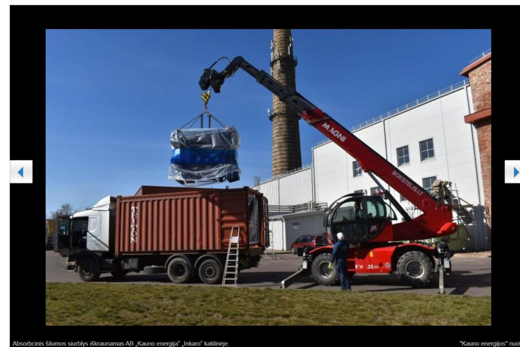
Absorbicinis šilumos siurblys iškraunamas AB „Kauno energija“ „Inkaro“ katilinėje.
