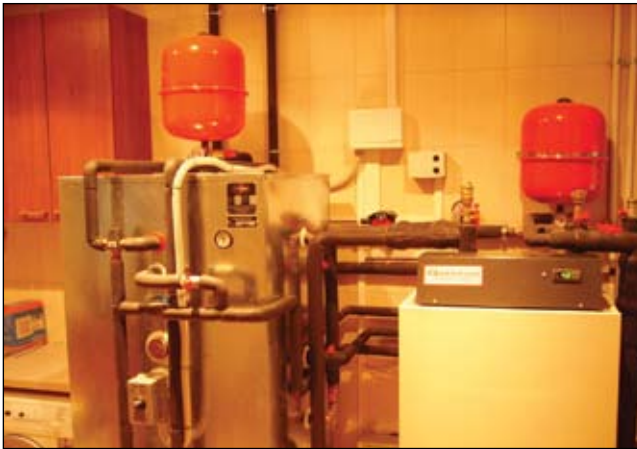
39 pav. Katilinė su šilumos siurbliu
