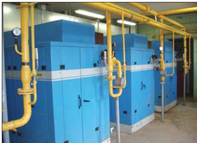
26 pav. Biodujų kogeneratoriai UAB „Lekėčiai“ biodujų jėgainėje
