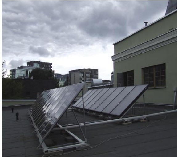
29.4 pav. Saulės elektrą gamina 15 fotoelektrinių modulių, saulės šilumą – 8 saulės kolektoriai.
