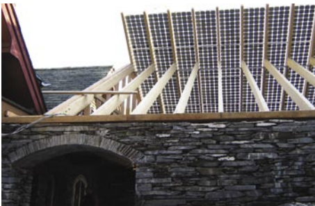
14.2 pav. Iš dalies užtamsinti stiklai su įmontuotais fotoelementais.
