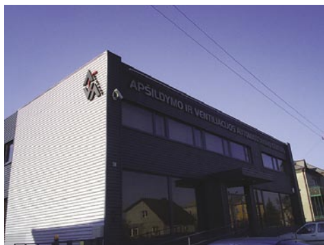
24.1 pav. Atnaujintas administracinis pastatas*.
