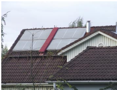
26.4 pav. Saulės kolektoriai sumontuoti ant stogų pietinių šlaitų.
