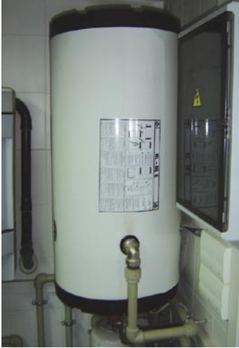
8.1 Tūrinis vandens šildytuvas. 8.2 pav. Maišytuvas. UAB Apšildymo ir ventiliacijos automatizavimo centras nuotr.
