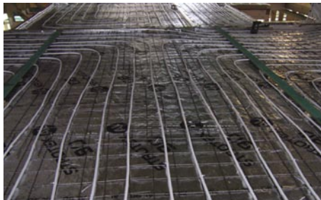
32.5 pav. Montuojamos šildomosios grindys. D. Surkio nuotr.
