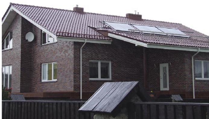
27.1 pav. Saulės kolektoriai sumontuoti ant stogo.
