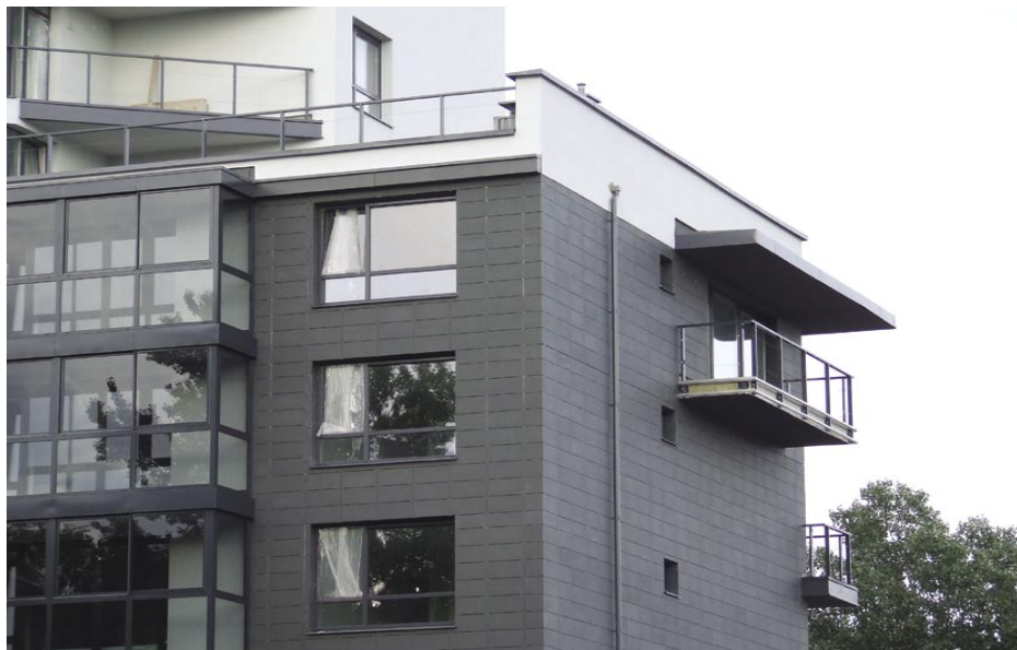
5.7 pav. Stogelis apsaugo į pietus orientuotą langą nuo saulės spindulių pertekliaus vasarą (dešinėje).
