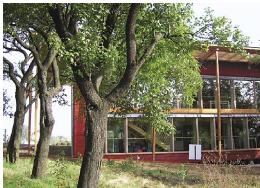
17.4 pav. Pietinis S-House fasadas. www.baubiologie.at archyvų nuotr.
