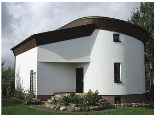
25.3 pav. Šiaurės rytų ir rytinė pastato pusė.
