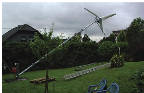
14.6 pav. Montuojama mažos galios horizontaliosios ašies vėjo jėgainė. UAB Tometa nuotr.
