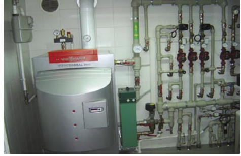
24.3 pav. Dujinis katilas (kairėje) katilinėje*.
