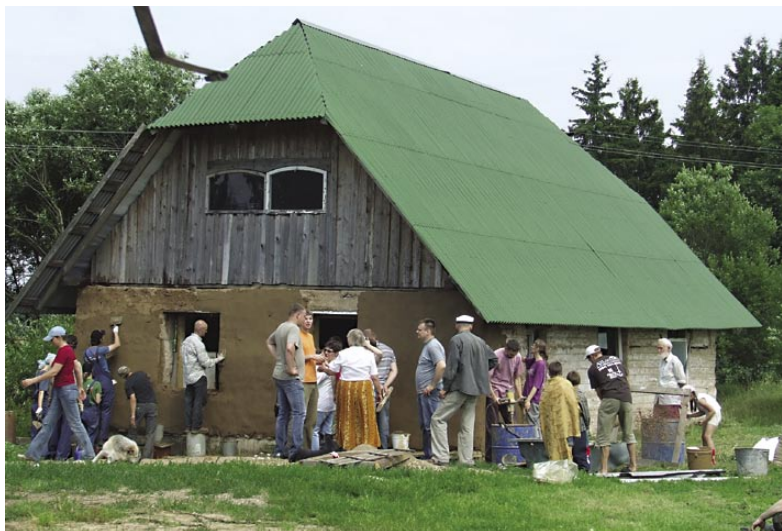
15.4 pav. Būsimoji amatų artelė ekologinio ūkininkavimo centre Vilniaus rajone – plūkta molio ir pjuvenų siena su įstrižiniais medienos atraižų ryšiais, tinkuojama molio tinku.
