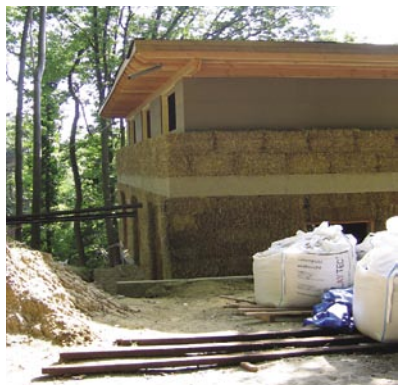
15.8 pav. Šiaudų ryšuliais šiltinamas statomas namas Belgijoje. H. Soomo nuotr.
