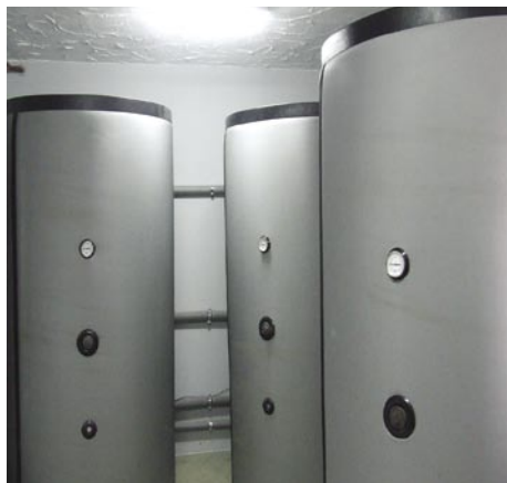
27.3 pav. Patalpų šildymo sistemoje yra kelios akumuliacinės talpos.
