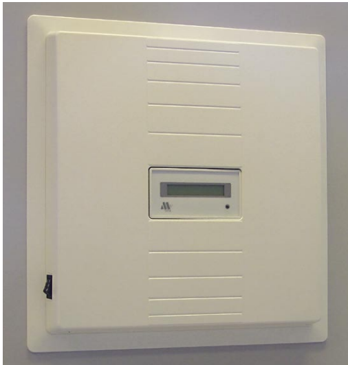
7.2 pav. Decentralizuoto gyvenamųjų namų vėdinimo sistema (šilumos atgavimas – iki 76 proc.).
