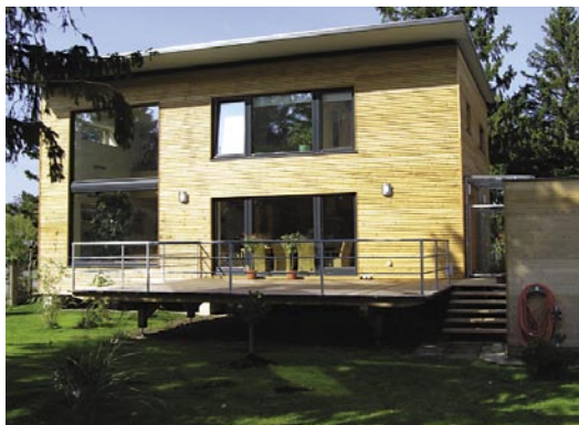
15.9 pav. Pasyvusis pastatas iš presuotų šiaudų skydų Austrijoje. Bendrovės Bauatelier Schmelz & Partner nuotr.
