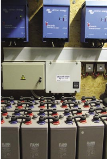
29.3 pav. Automatizuotas elektros energijos kaupimas, keitimas ir naudojimas.
