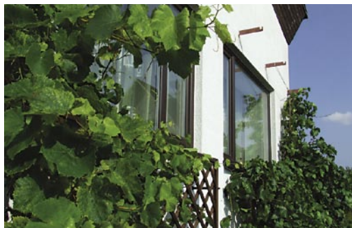
25.5 pav. Pietiniai langai, virš jų bus montuojami saulės kolektoriai vandeniui šildyti.
