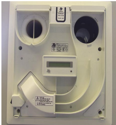
7.3 pav. Vėdinimo sistemos vaizdas, nuėmus dangtį.
