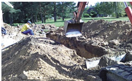
32.4 pav. Įrengiamas horizontalusis kolektorius.
