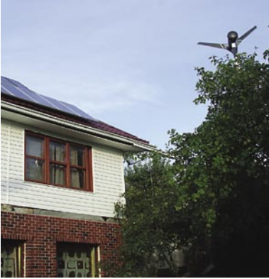
30.1 pav. Saulės kolektoriai ir fotoelementai, sumontuoti ant stogo.
