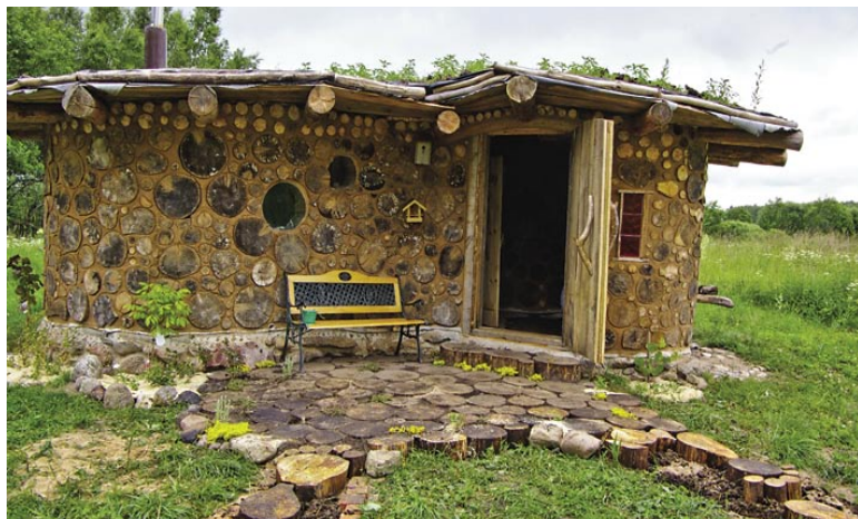
15.2 pav. Vilniaus rajone esančios pirtelės sienos sumūrytos iš apvalių malkų, naudojant molio skiedinį, stogas apželdintas. J. Pečiulio nuotr.
