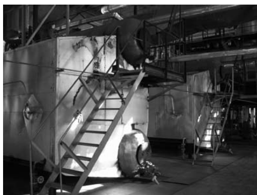
8.21 pav. DE tipo katilas Võrusoo katilinėje, vaizdas iš galo. Ū. Kask nuotrauka
