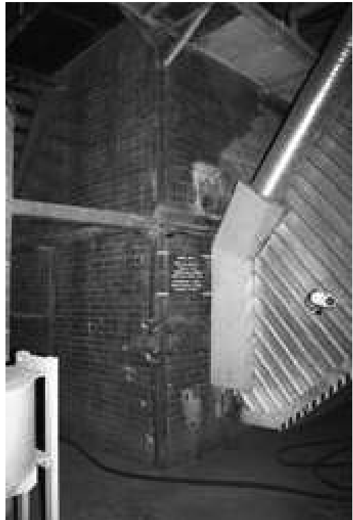
8.17 pav. Tolimasis tretinio oro kanalo galas. Ū. Kask nuotrauka
