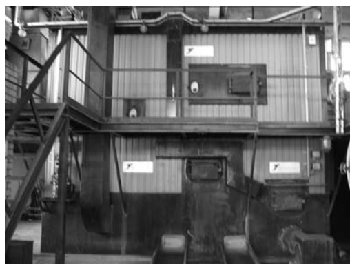
8.22 pav. Prieškūrykla, įrengta Võrusoo katilinėje. Ū. Kask nuotrauka
