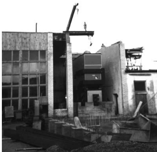
8.6 pav. Biokuro katilo montavimas Tehnika katilinėje Tūri mieste. V. Vares nuotrauka
