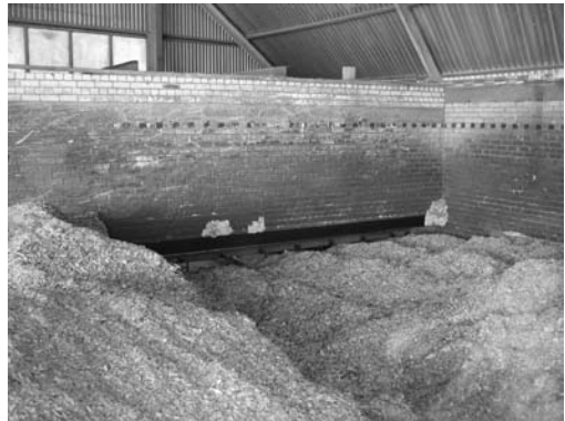
8.24 pav. Kuras Võrusoo katilinės sandėlio skyriuje, kuriame įrengti hidrauliniai stumtuvai. Ü. Kask nuotrauka.
