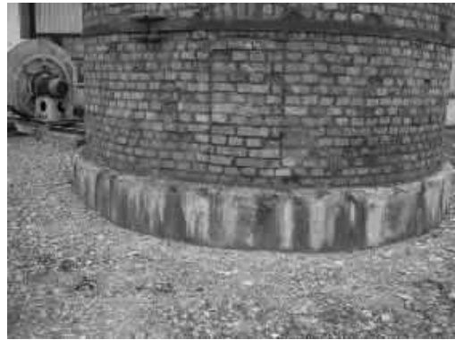
8.12 pav. Trupančios plytos yrančio kamino pagrinda. Ū. Kask nuotrauka
