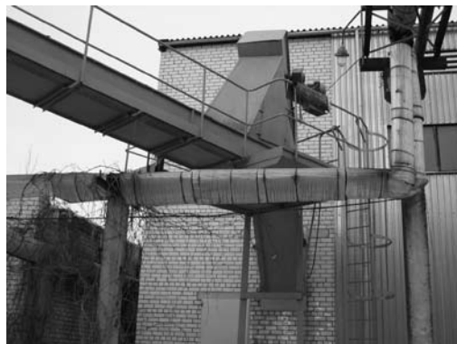
8.19 pav. CŠT vamzdynai, trukdantys įrengti planuotus transporterius iš sandėlio į katilinę. Ū. Kask nuotrauka
