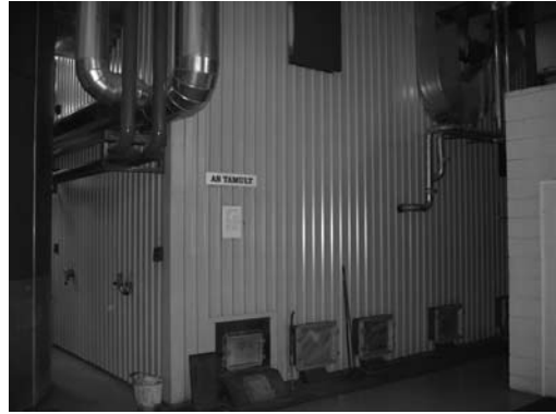
8.37 pav. Prieškūrykla Keila katilinėje. Ū. Kask nuotrauka
