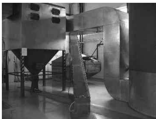
8.41 pav. Multiciklonas ir pelenų transporteris. Ū. Kask nuotrauka
