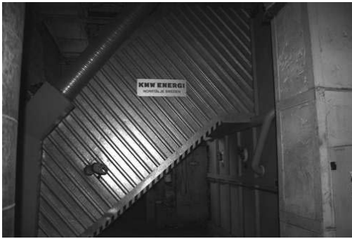
8.16 pav. Dūmtakis tarp priešškūryklos ir katilo. Ū. Kask nuotrauka
