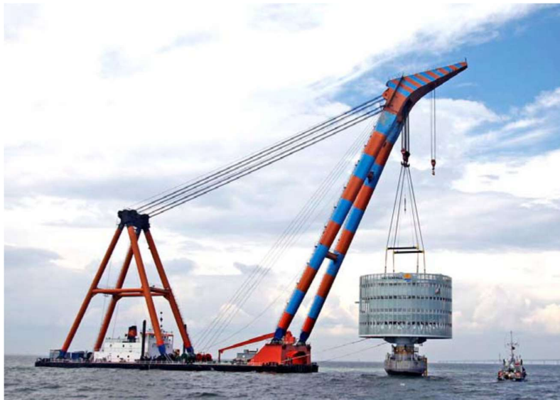
4.2.5 pav. Elektros pastotės montavimas Lillgrund VE parke (nuotrauka iš Jeppsson J. et al. 2008).
