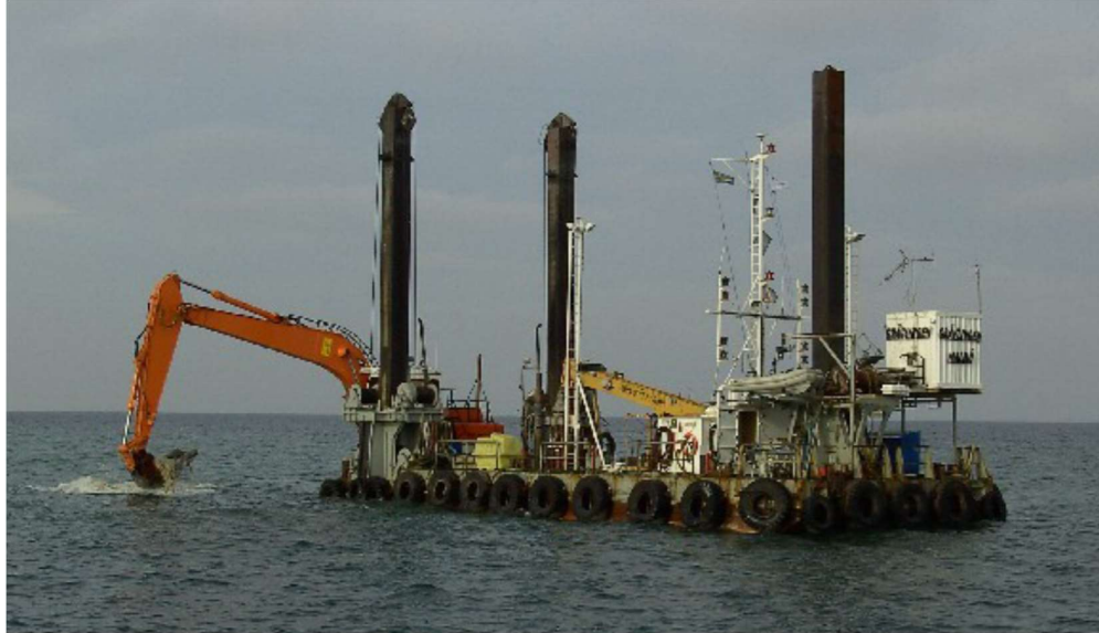
4.2.4 pav. Dugno paruošimas jūrinio kabelio klojimui (nuotrauka iš Jeppsson J. et al. 2008).
