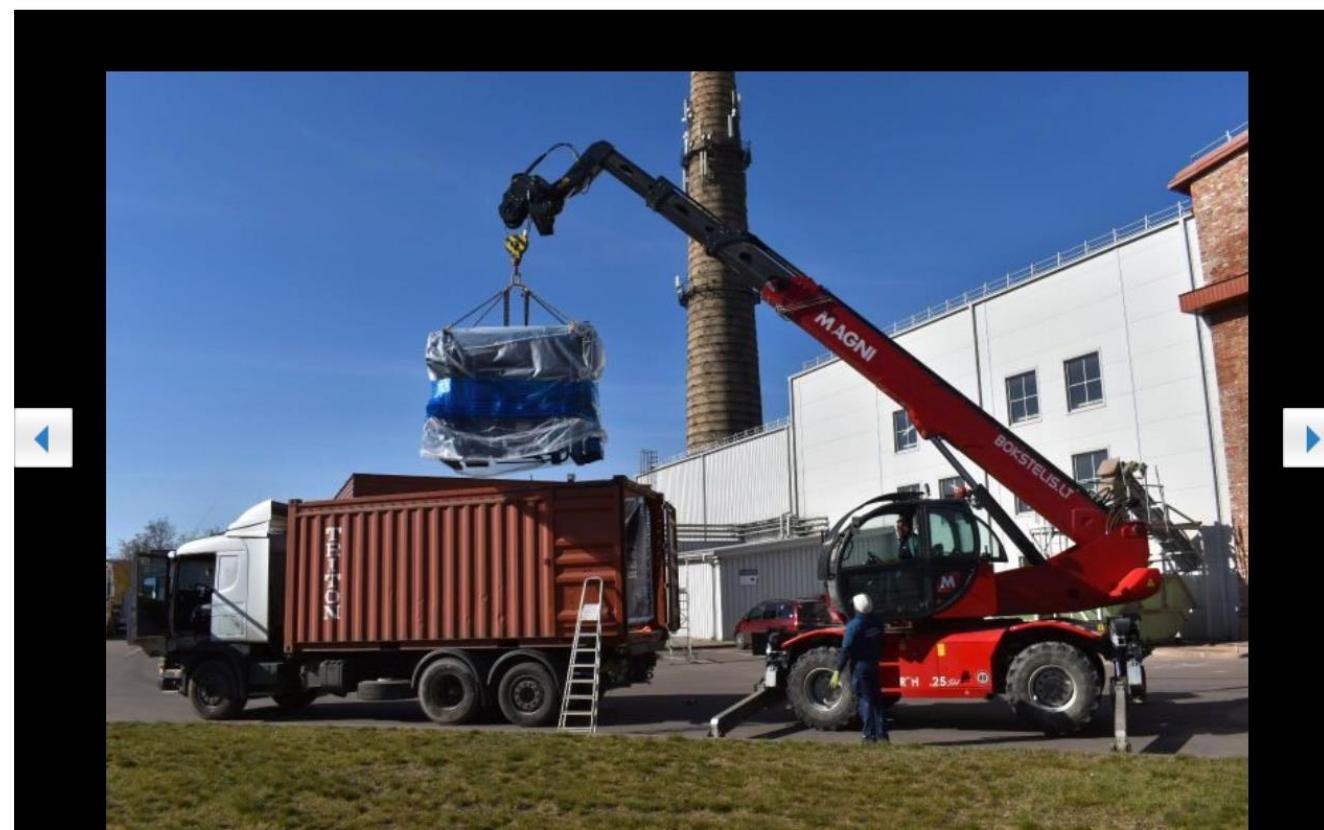
Absorbcinis šilumos siurblys iškraunamas AB „Kauno energija“ „Inkaro“ katilinėje.
