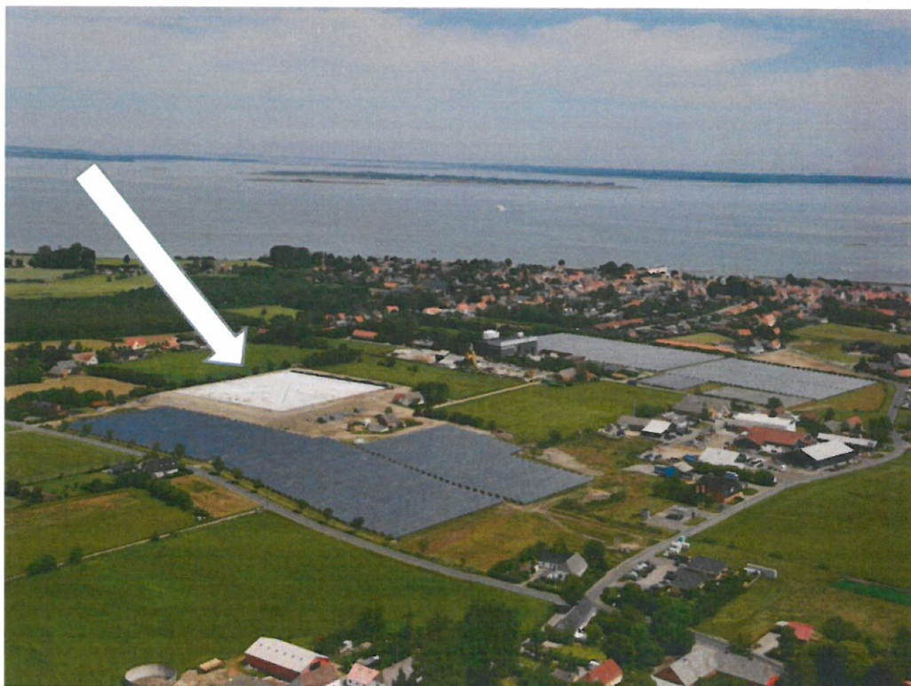
5.1 pav. CŠT saulės kolektorių sistema [Leo Holm, „Sunmark Solutions“, Danija]
