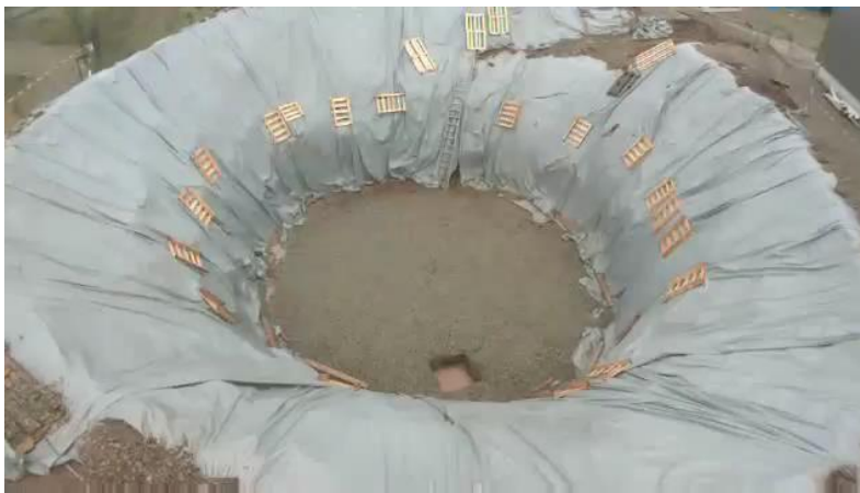
4.6 pav. Terminės saugyklos statyba
